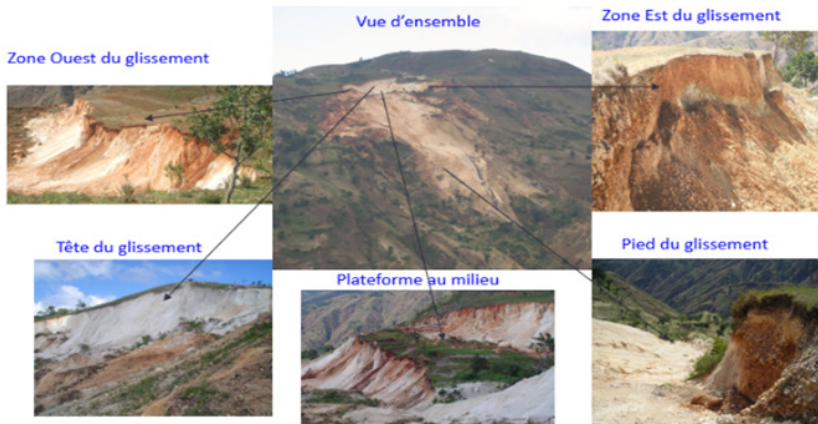
Le glissement de terrain de Mahotières – Kenscoff
